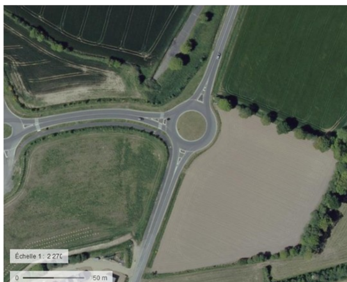
Giratoire réalisé à l'emplacement réservé n°51
