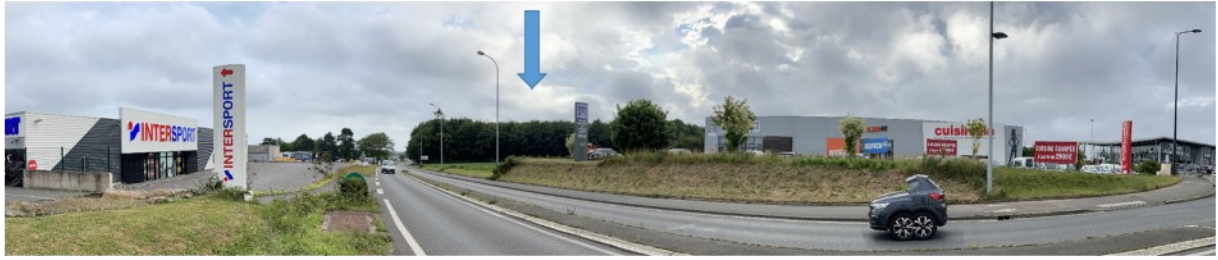
Vue du site depuis la RD788 au sud
