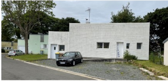
Exemple de bardage horizontal
