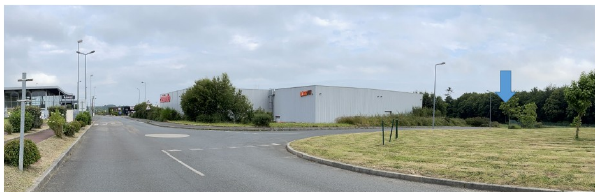
Accès existant rue Lucien Vidie
