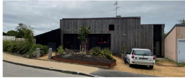
Exemple de bardage vertical
