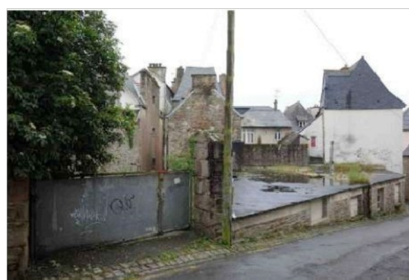
Vue de l'accès de la cour à gauche avec l'ancienne église évangélique à droite (bâtiment semi-enterré devant être rasé).
