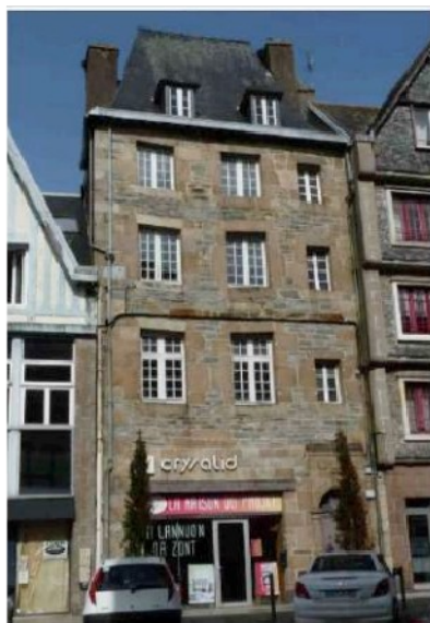
Vue de la façade principale rue du Général Leclerc.
